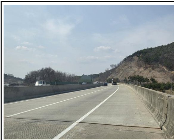
위 치 교면포장 현 황 전경
