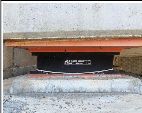
위 치 교량받침 현 황 전경
