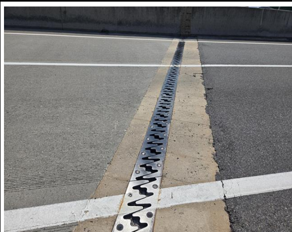
위 치 신축이음 현 황 전경
