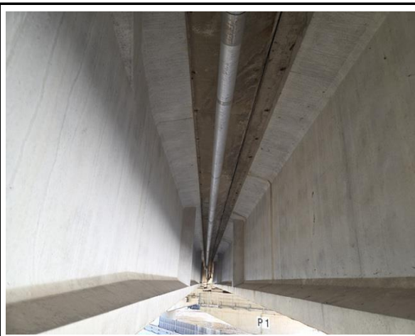
위 치 배수시설 현 황 배수관 전경
