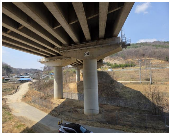
위 치 교각 현 황 전경
